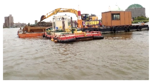
浚渫現場の様子
